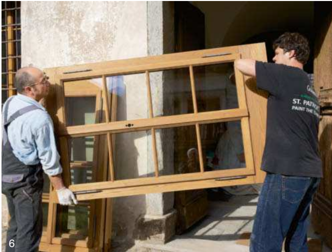
6— Im März 2015 wurde die zweite Serie neuer Fenster geliefert (Vogel Fensterbauer AG, Goldach). Es handelt sich um Nachbauten aus Kastanienholz von zur Bauzeit verbreiteten Barockfenstern.
