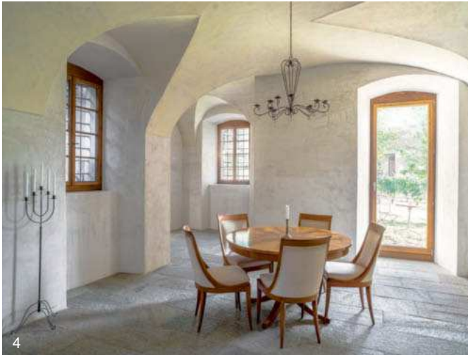
4— Im Erdgeschoss hat die Wohnbibliothek mit Gewölbe und Steinboden (von Hand behauene Gneisplatten) ihre ursprünglich schlichte Strenge wiedergewonnen. Links Blick in den Eckturm.
