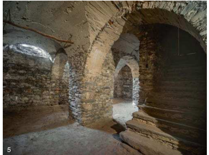
5— Die Kellerräume mit Kreuzgewölbe wurden von Trennwänden befreit und zeigen heute wieder ihre ganze Monumentalität, unterstrichen von den massiven Natursteinmauern.
