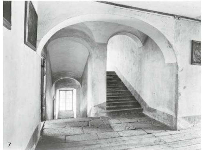
7— Um separate Wohnungseingänge zu schaffen, wurden in den 1950er-Jahren der Treppenaufgang und die Korridore unterteilt. Bald werden auch diese Räume wieder zu ihrer 1938 dokumentierten Grosszügigkeit zurückfinden. (Foto: Rudolf Zinggeler, 1938. Quelle: Schweizerische Nationalbibliothek/NB, Bern)
